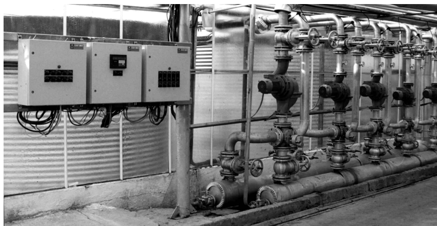
Рис. 3. Подсистема управления микроклиматом теплицы площадью 1 га
